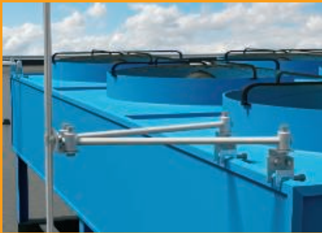
Isolierter Blitzschutz und OBO isCon-System
