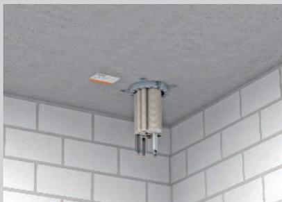
Montage an der Deckenunterseite mit Metalldübeln.
