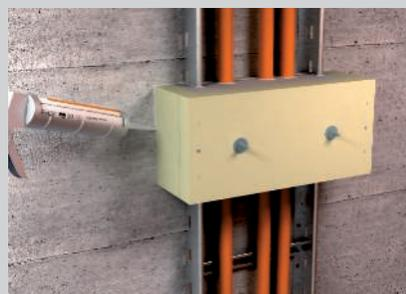
Verschließen aller Restfugen mit der Brandschutzmasse ASX.
