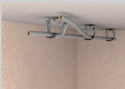
Öffnen der Sammelhalterung und Einlegen der Kabel.
