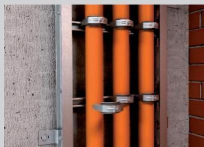
Kabelinstallation mit Bügelschellen 2056 UM an den Sprossen der Steigeleiter.
