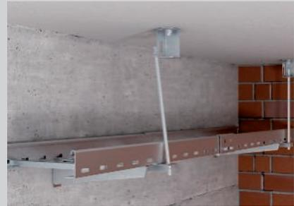
Deckenbefestigung der Gewindestangen mit Brandschutzbügel.
