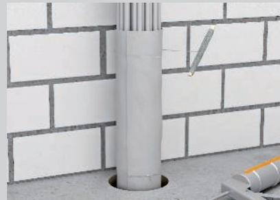
Fixieren der Bandage mittels Wickeldraht.
