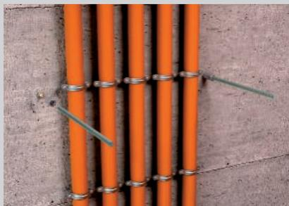
Befestigungspunkte neben den Kabeln direkt an der Wand bei Schraubabstandschielen.
