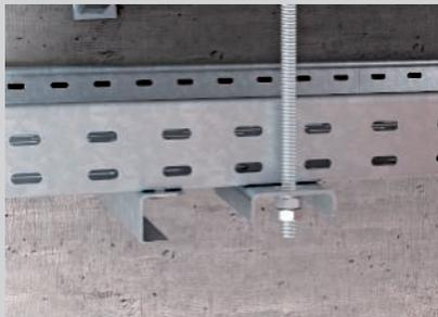
Befestigung der senkrechten Gewindestange an der untersten Kabelrinne.
