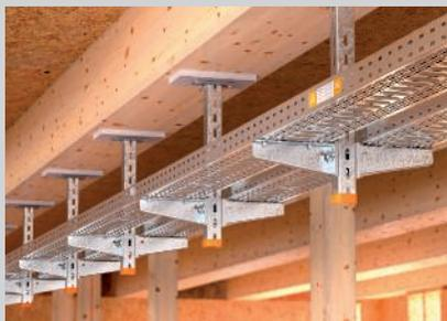
Hängestielmontage unter dem Holzbalken mit hinterlegter Brandschutzplatte.
