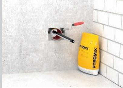
Verschließen der Öffnung mit Mörtel PYROMIX®.
