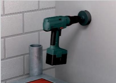
Bohren eines Lochs mit einem Dosenbohrer.
