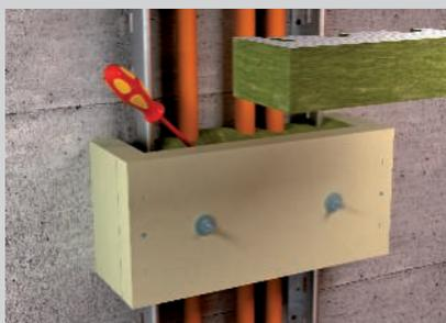
Vollständige Füllung des Gehäuses mit Mineralwolle und einsetzen der oberen Mineralfaserplatte.
