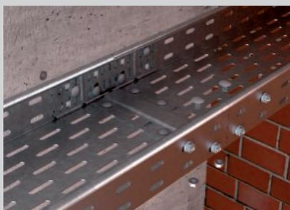
Längsverbinder und Stoßstellenleiste mit Flachrundschrauben befestigen.
