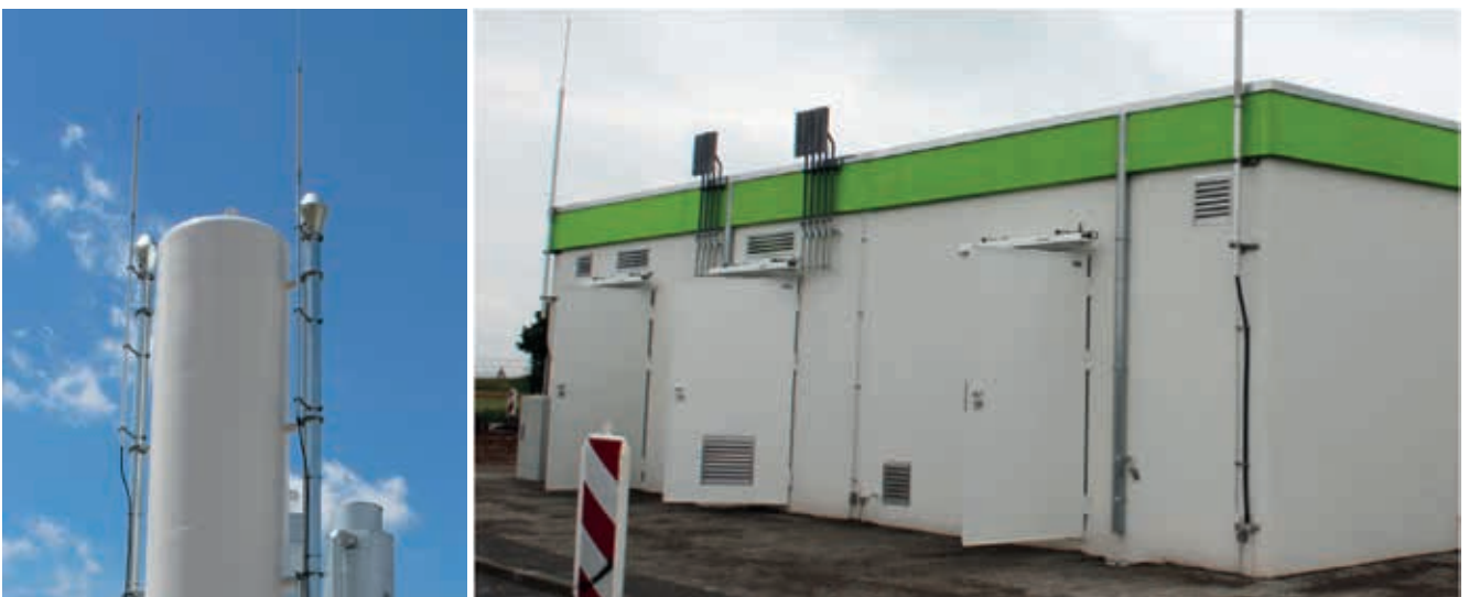
Abb. 7: Wand- und Rohrmontage: innenverlegte isCon ® -Ableitung in Fangmast an Biogas-Anlage
