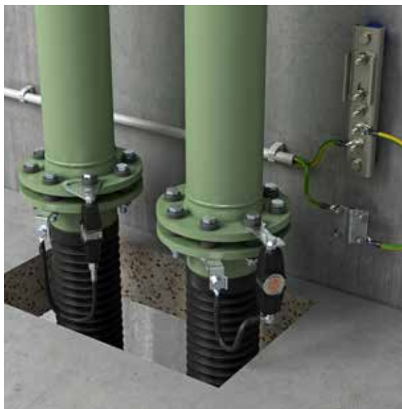
Abb. 4: Trennfunkenstrecke an Isolierstücken montiert
