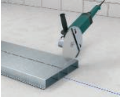
Schneiden des Kanals Die Stahlblechkanäle lassen sich am einfachsten mit einem Einhand-Winkelschleifer bearbeiten. Saubere Schnitte sowie die anschließende Entgratung sind wichtig für eine schonende Installation der Kabel und Leitungen.
