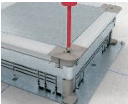
Feineinstellung der Dosenhöhe Mithilfe eines Schraubendrehers (Pozi-Driv Gr. 2) kann die Höhe der Unterflurdose eingestellt werden.
