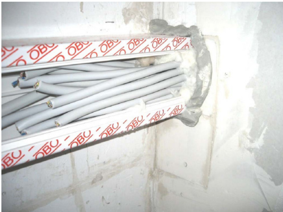
Geräteinbaukanal aus PVC, Kanal mit 50 % Kabel und Glaswolle befüllt
