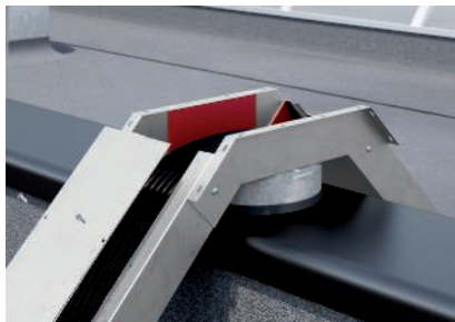
Montage des Kanaldeckels nach der Kabelverlegung.
