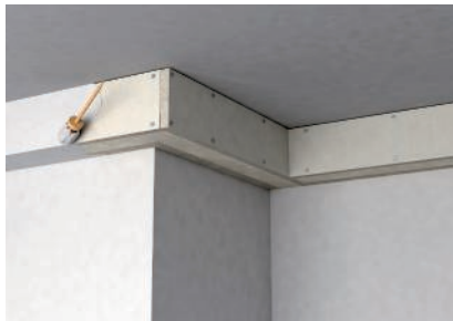
Abschließende Oberflächenbehandlung durch Streichen oder Tapezieren.
