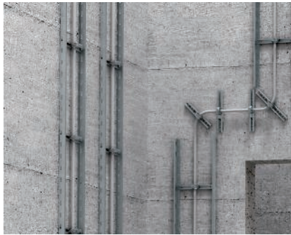
Darstellung Steigeschacht Darstellung einer fertigen Steigeleiternmontage.
