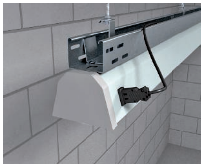
Vorkonfektionierte Leuchtränger Montage einer vorkonfektionierten Leuchte unterhalb einer Leuchträngerschiene.
