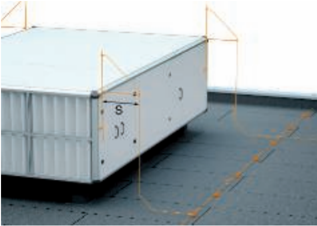
Beispiel: Fangsystem mit Iso-Combi-Set für Dreiecksbefestigung
