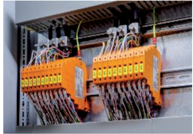
Anschluss der Kabelschirme mit der SAS-Bügelschelle zum Anschluss des Schirmgeflechtes und MDP-Überspannungsschutzgeräten
