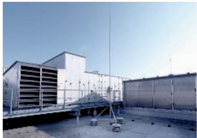
Isolierter Blitzschutz mit isFang
