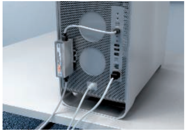
Schutzvorschlag am Endgerät. Um den Schutzpegel gering zu halten, nutzt das Überspannungsschutzgerät als PE-Verbindung den Schutzleiter des PC-Gehäuses
