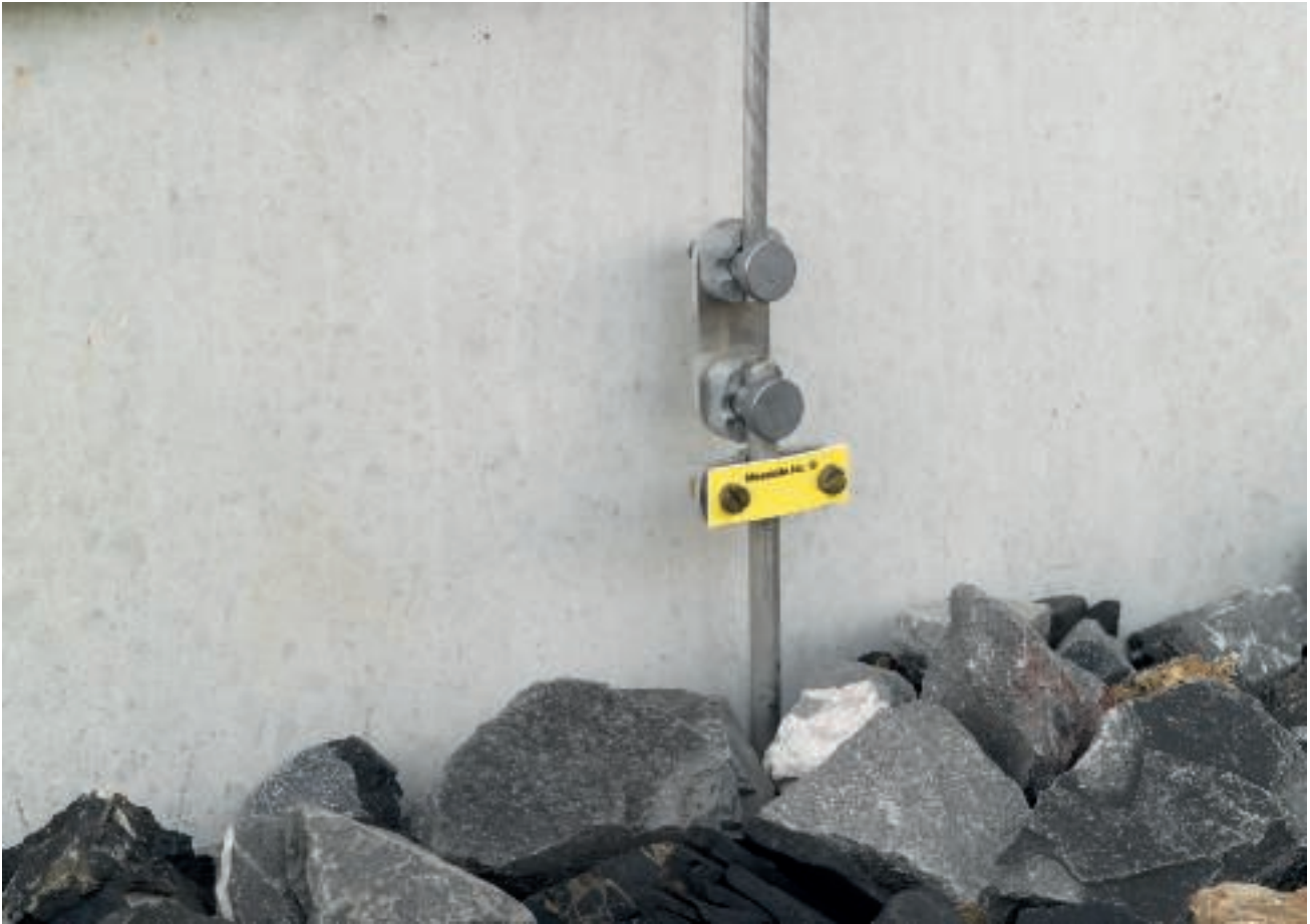
Trennstelle an einer Metallfassade
